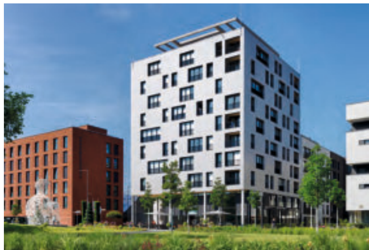
In Heilbronn war 2019 mit dem SKAIO das erste Hochhaus in Holz-Hybrid-Bauweise errichtet worden. | Foto Bernd Borchardt
