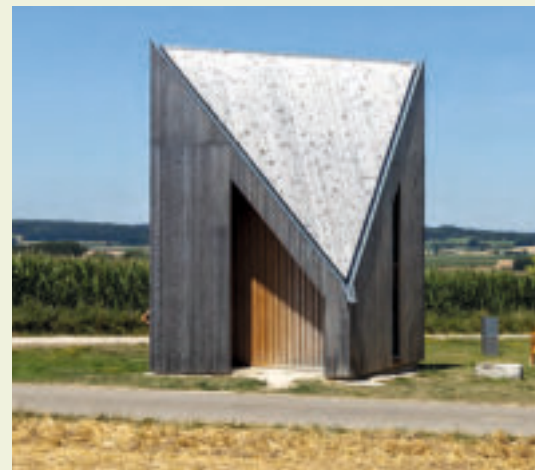
Wegkapelle in Oberbechingen am Radweg nach Dattenhausen. Der Blick durch das Stabwerk der nach innen verschwenkten Wand lässt den Innenraum erahnen. Architekt Frank Lattke | Foto H. Grandel
