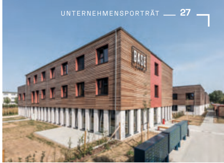
Das „Base Camp“ Studentenwohnheim Golm-Potsdam wurde 2017 schlüsselfertig errichtet. | Foto Steffen Spitzner
