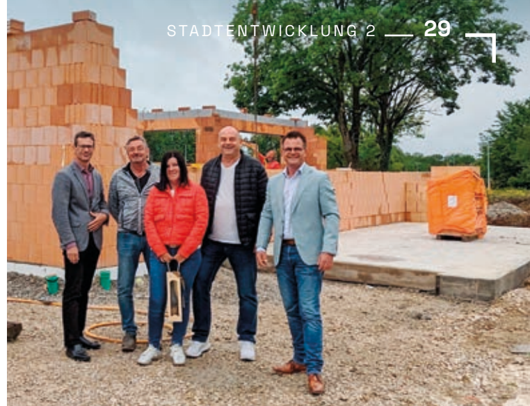
Die ersten Hausmauern stehen. Darüber freuen sich (v.r.): OB Jürgen Sorré, Gerd und Sandra Morlok, Bauunternehmer Adolf Kratz und Stadtbauamtsleiter Robert Strasser.
